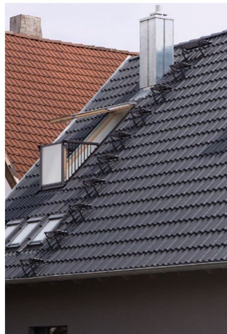
Nosná škridla s držiakom stúpajúcej plošiny
